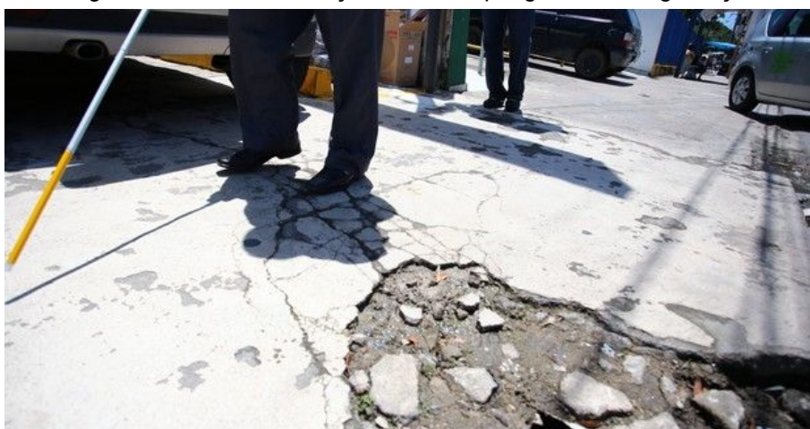
Figura 3 - Buracos na calçada causam perigos a sua segurança.
