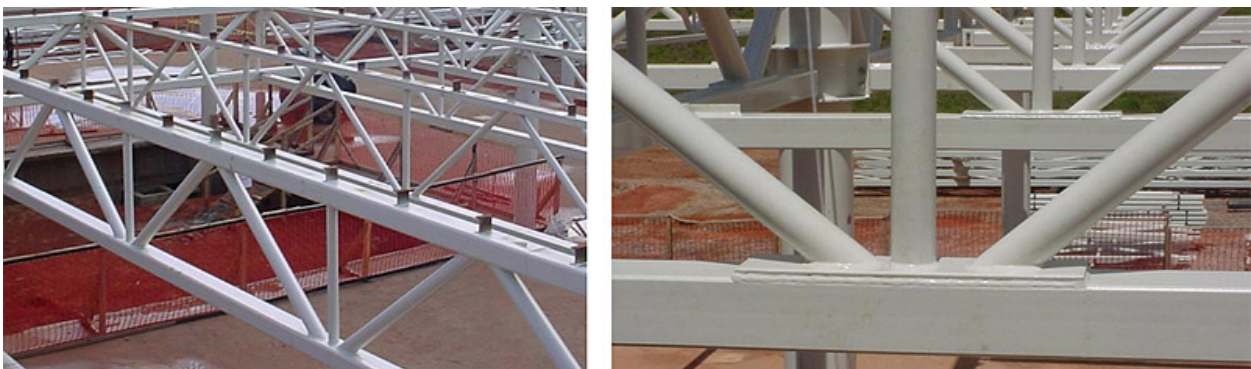
Figura 1 – Exemplo de ligação tubular tipo KT
